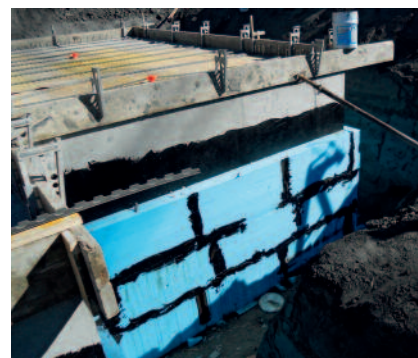
Etancher et coller de l'isolation thermique avec le revêtement épais PCI Barrapren.
