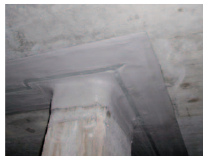
Bande d'étanchéité PCI Pecitape 3000 collée avec PCI Barrafix EP.
