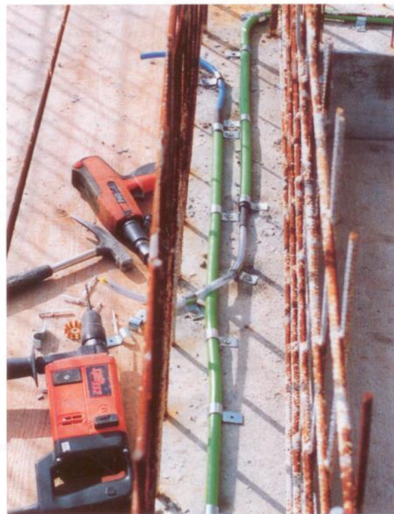
Exemple d'emploi: Joint de construction puits d'élevateur
